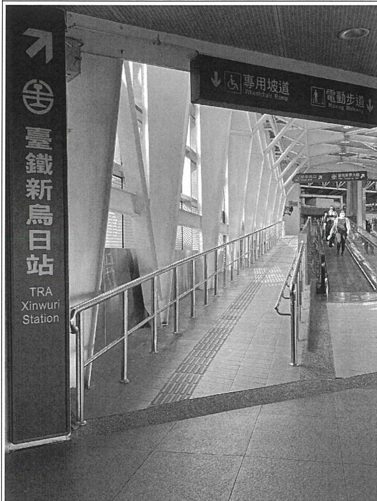
圖1、臺中捷運至高鐵站聯通之斜坡道設置導盲磚且端部斜率不一
